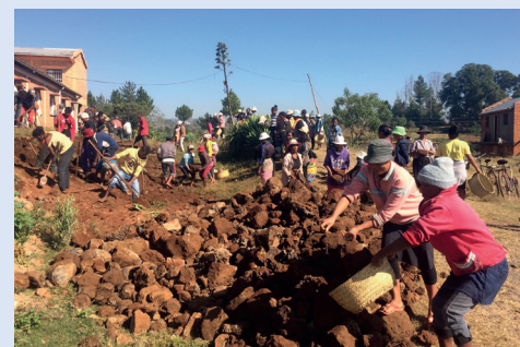
Hier entsteht das neue Schulhaus.
