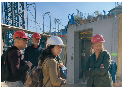
Inspektion der Baustelle Nidelbadstrasse 64
